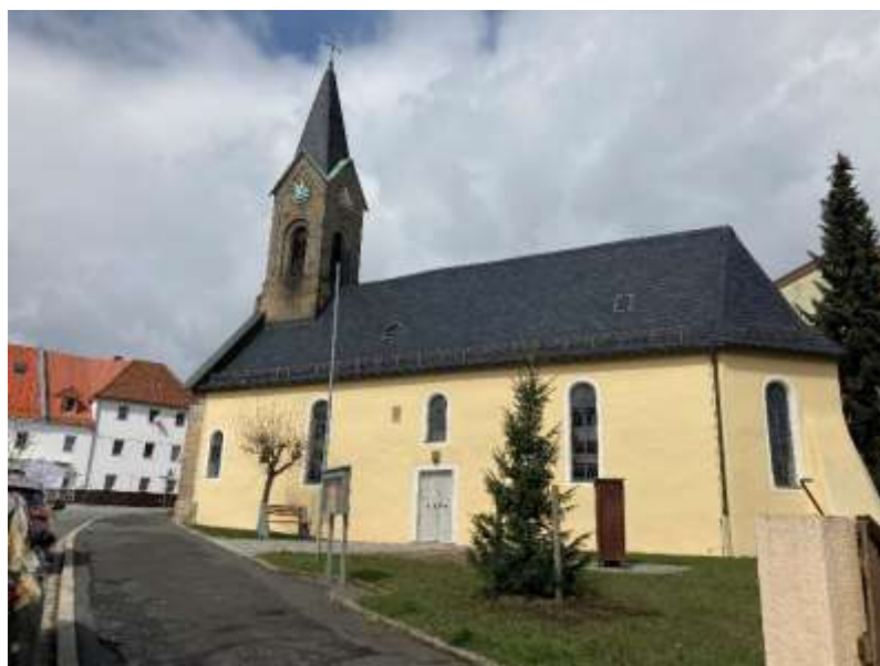
Baudenkmal D-4-79-136-38, (eigenes Archiv 2021)
