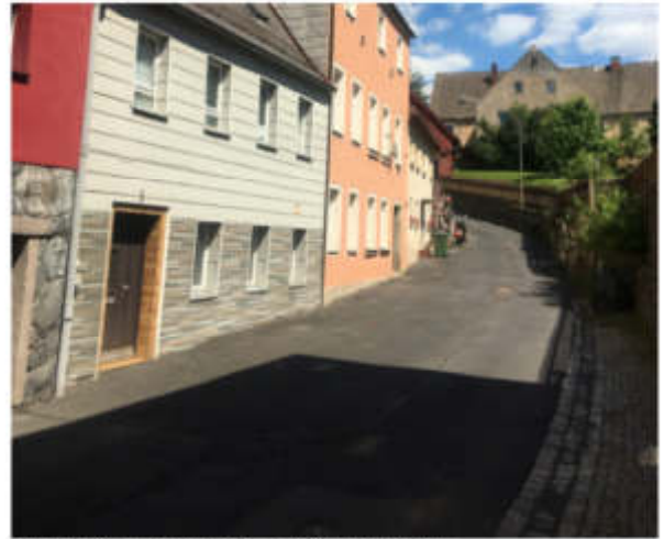
Bühstraße - Ungeordnete Gebäudeanschlüsse
