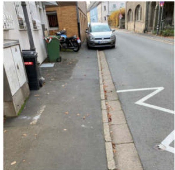
Dörflaser Hauptstraße - Fehlende Freiräume
