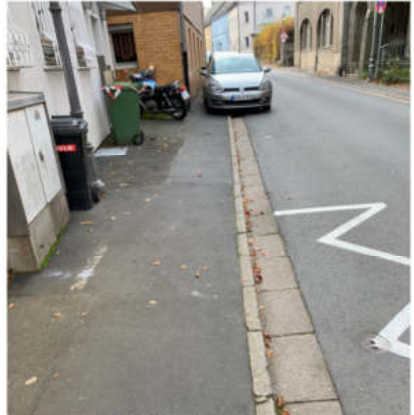
Dörflaser Hauptstraße - Fehlende Freiräume
