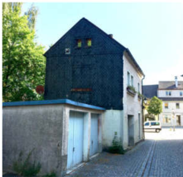
Stellplatzsituation / Errichtung von Fertiggaragen.
