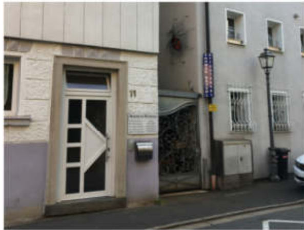
Mängel in der Fassadengestaltung
