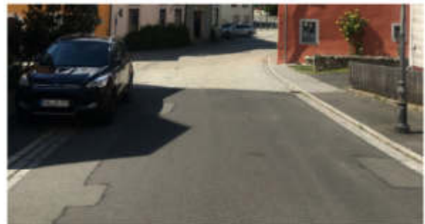
Hohe Gasse - teilsanierte Straßenabschnitte
