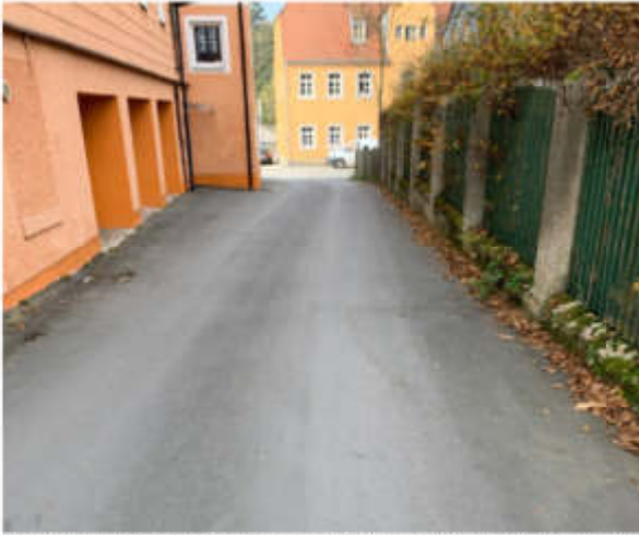
Weberweg - vollflächige Asphaltierung / ohne Oberflächengestaltung
