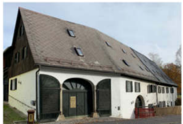
Friedenfeiser Straße 27 - Wuttigmühle; Wohnstallstadelhaus
