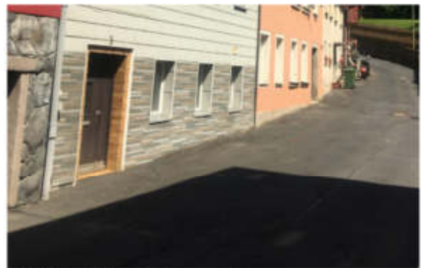
Bühlstraße - fehlende Gebäudeanschlüsse
