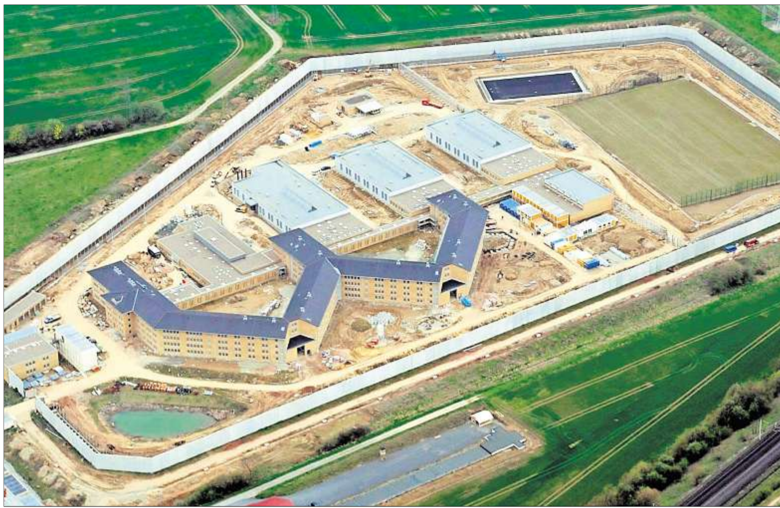
So könnte das künftige Marktredwitzer Gefängnis einmal aussehen. 314 Haftplätze bietet die Justizvollzugsanstalt Rosdorf bei Göttingen in Niedersachsen. Das Gefängnis wurde komplett neugebaut und ging im Jahr 2007 in Betrieb. Unser Bild zeigt die Anlage kurz vor der Fertigstellung.
