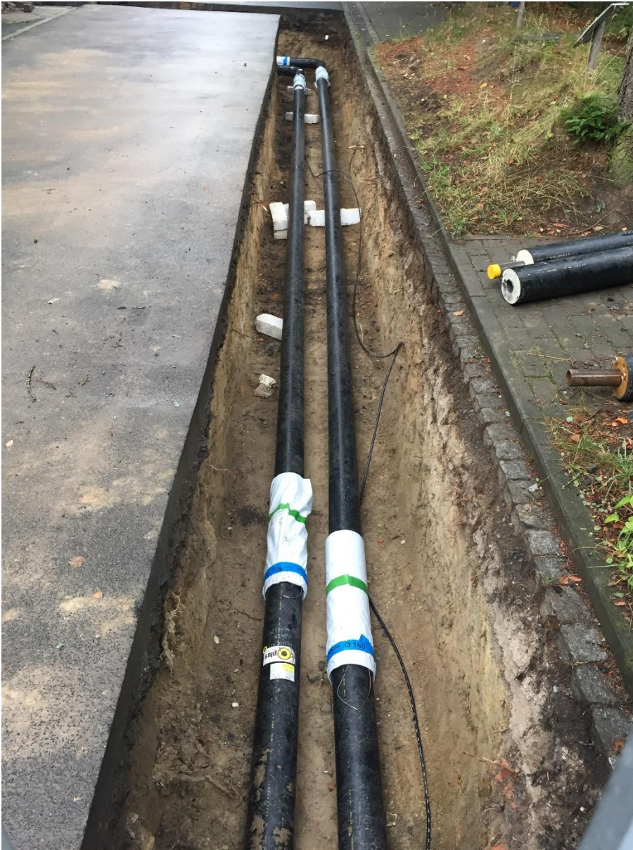
Abbildung 2: Leitungsgaben Nahwärme mit Vor- und Rücklaufleitung
