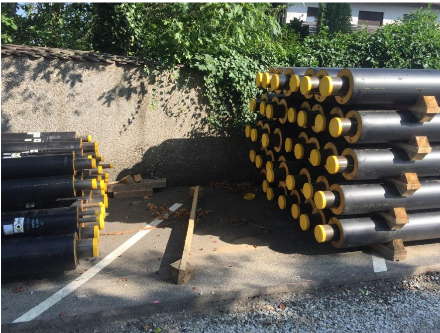
Abbildung 1: isolierte Stahlrohre für Nahwärmeleitung
